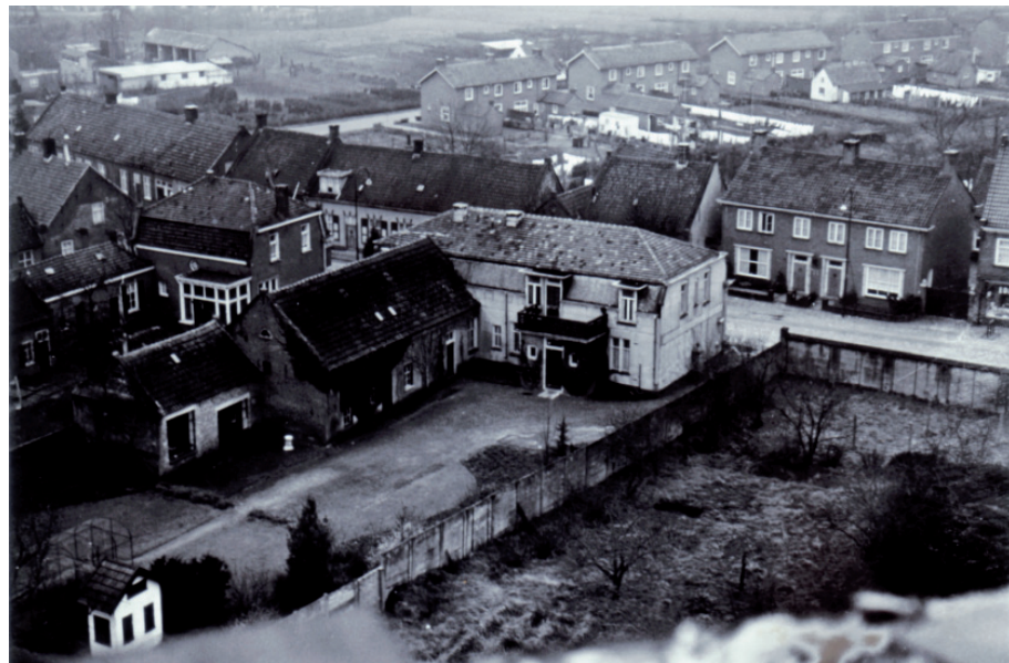
Afb. 5.29 Het pand van Van Amstel, gezien vanuit de kerktoren.
