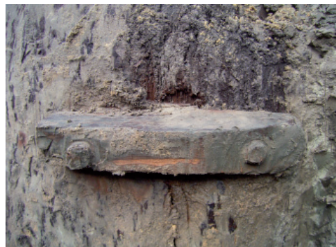
Afb. 5.24 Detailfoto verbindingstuk waterput HMW3.
